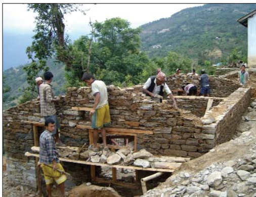
सामुदायिक अध्ययन केन्द्रको निर्माणधीन भवन (दुवाचौर गाविस, सिन्धुपाल्चोक)
